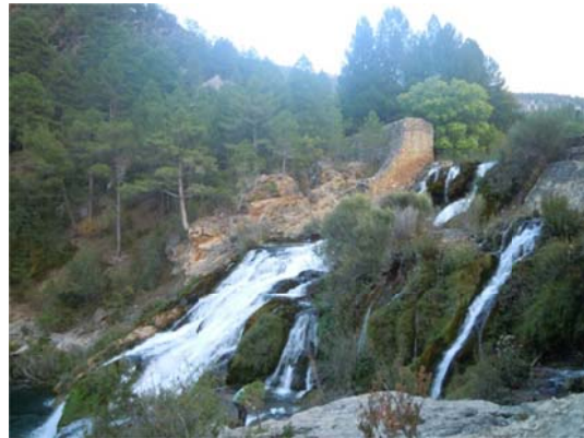
Instalaciones del salto de Poveda, que nunca llegó a ponerse en funcionamiento.
